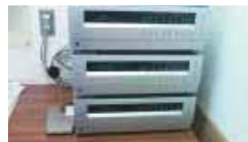
加茂区...屋外放送設備
