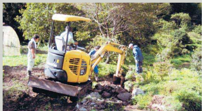
水路の堆積土砂を取り除いている様子。地域住民11名の皆さんが参加し5カ所の現場で作業が行われました。
